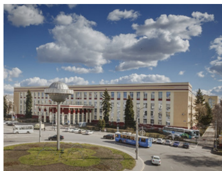
Главный корпус университета Main building
