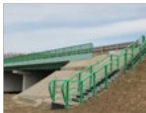
Путепровод на км 115 а/д М-2 "Крым"
