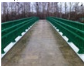
Надземный пешеходный переход на км 127+965 а/д М-4 "Дон"
