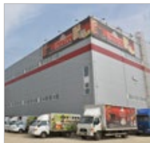
Фабрика и склады
