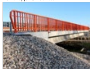
Мост через р. Федоровка на км 100+857 а/д А-119, Вологодская область
